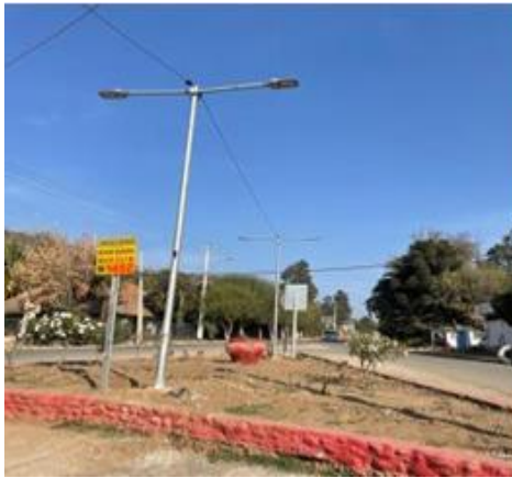
Fotografía 21. Instalación de 02 postes de gancho doble con 04 luminarias led, en ingreso principal a Pomaire, cruce calles San Antonio y Roberto Bravo.
