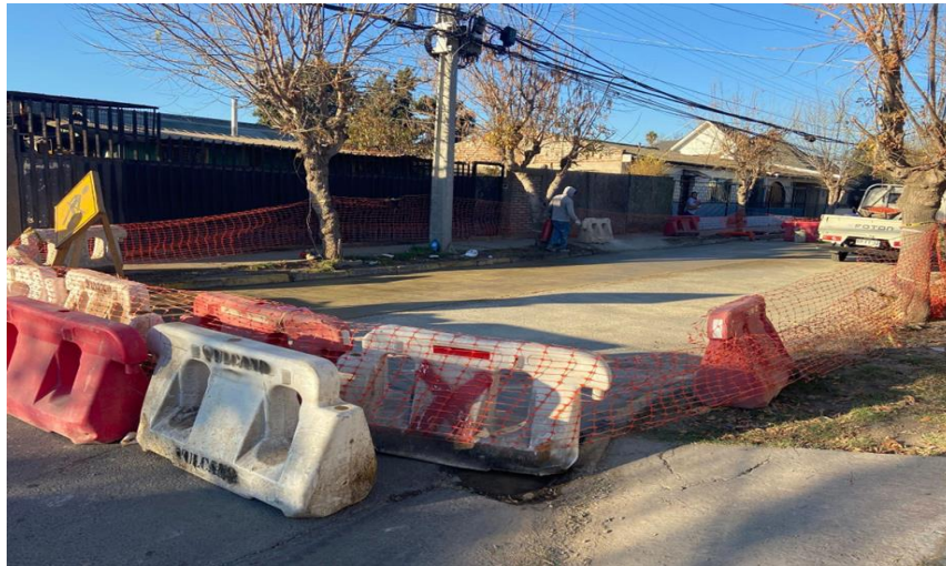
Fotografía 5. Construcción Intervenciones Definitivas de Emergencia Diversos Sectores
