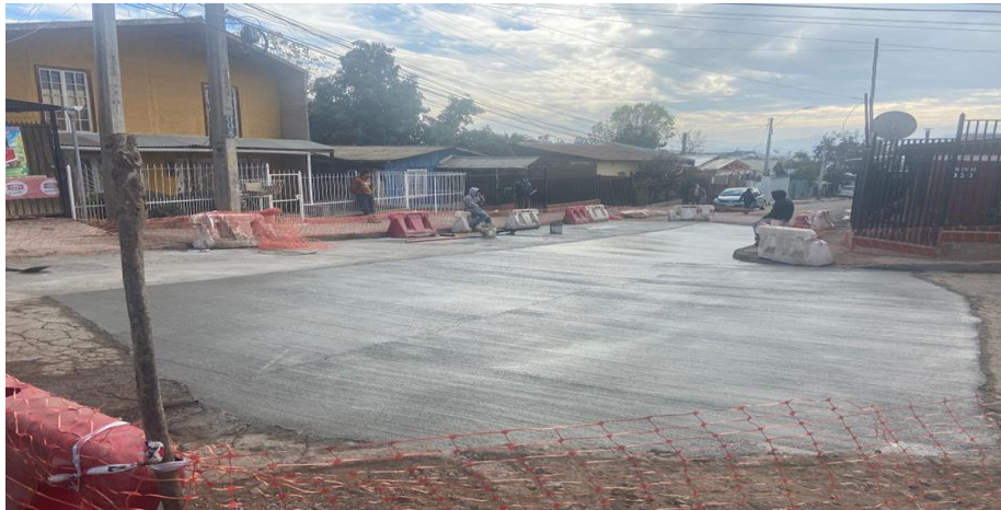
Fotografía 9. Construcción Intervenciones Definitivas de Emergencia sector Poniente
