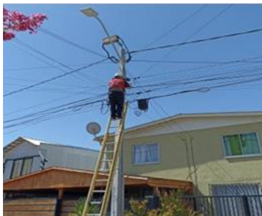
Fotografía 29. Reparación de circuito de Alumbrado Público, instalación de proyector en remplazo de luminaria.
