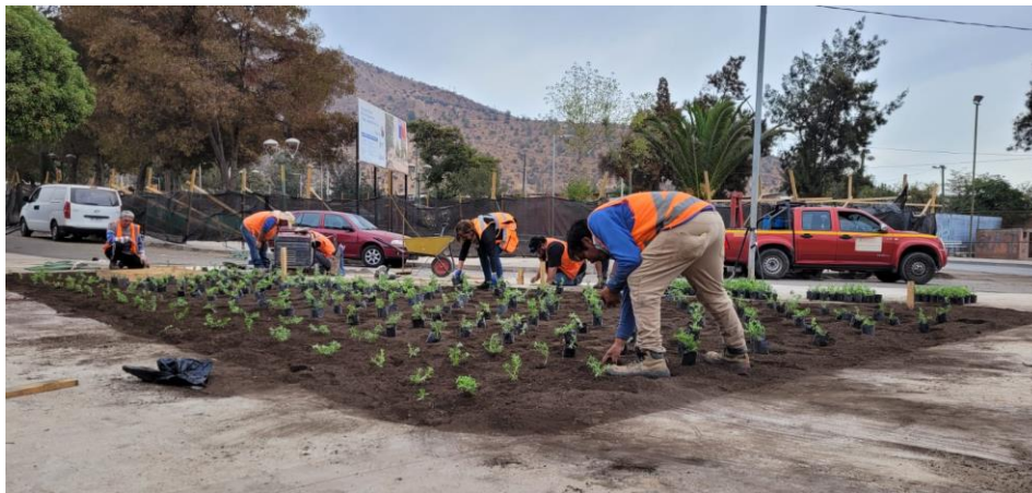
Fotografía 35. Inicio de Obra "Recuperación de Circulaciones Plaza Cementerio Sur"
