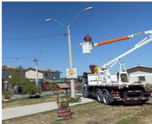
Fotografía 28. Reparación circuito de Alumbrado Público y conexión de luminarias.
