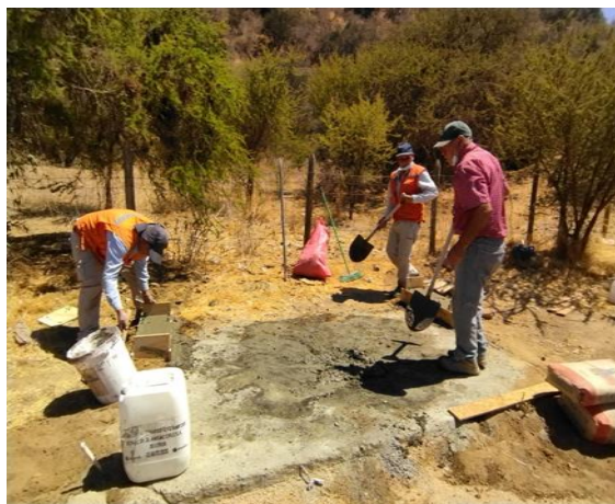
Fotografía 15. Instalación Refugio Peatonal, Tantehue.
