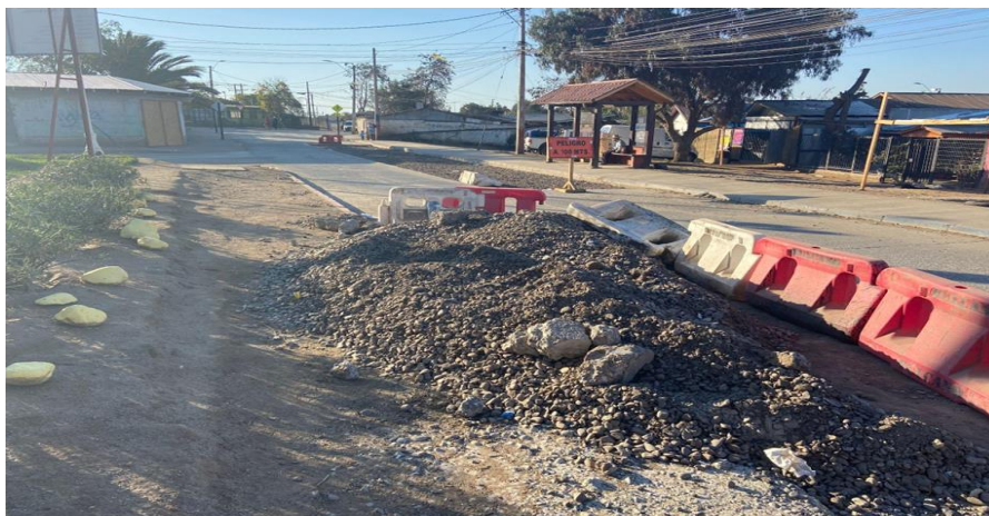
Fotografía 8. Construcción Intervenciones Definitivas de Emergencia sector Poniente.
