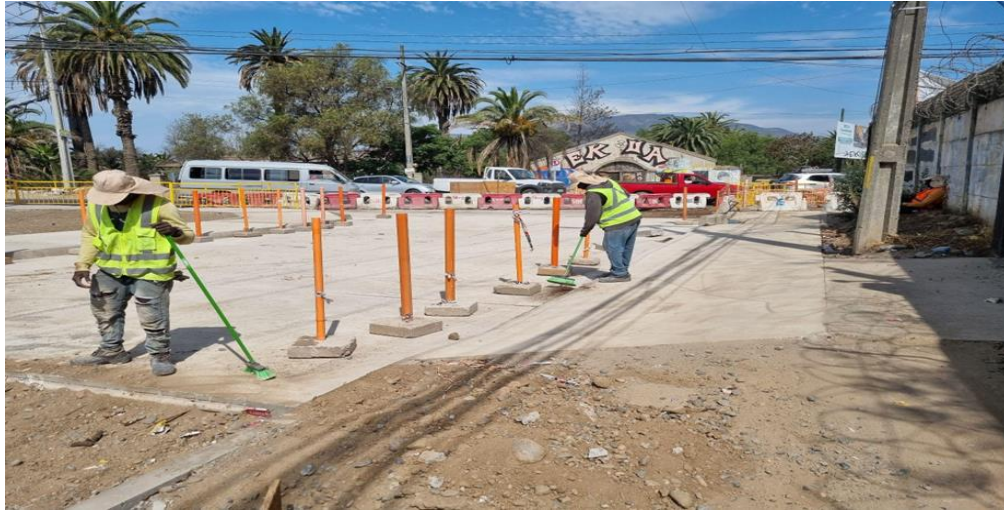
Fotografía 3. Mejoramiento Cruce El Pimiento
