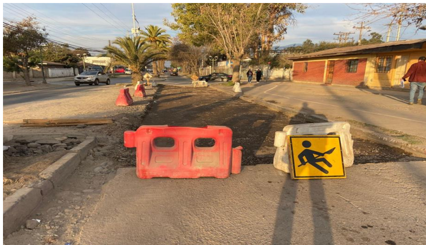
Fotografía 4. Construcción Intervenciones Definitivas de Emergencia Diversos Sectores
