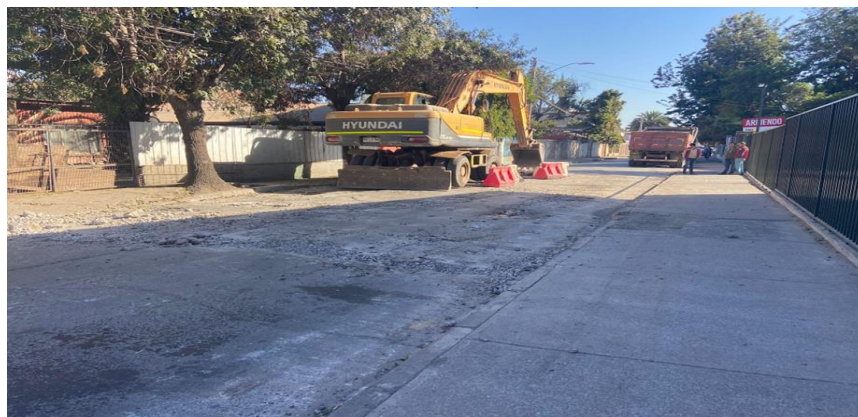
Fotografía 7. Construcción Intervenciones Definitivas de Emergencia sector Oriente, Comuna de
